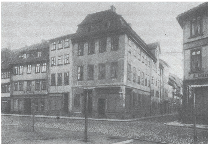
Das "Stammhaus" Pauliner Straße 15, kurz vor dem Abbruch
